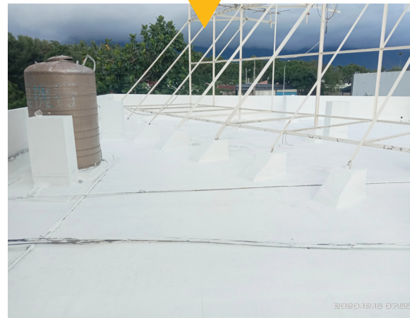
▲ 防水工程施工前中後實況（由上至下）
