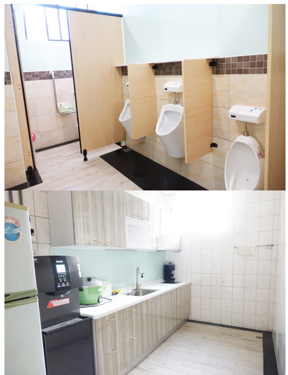
▲ 修繕完成的廁所及茶水間
