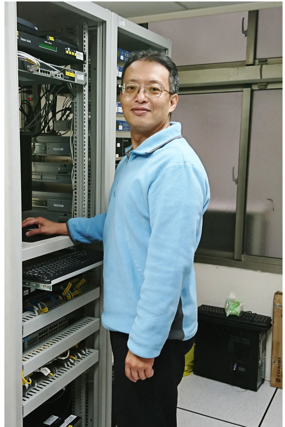
▲ 張森厚 - 監視系統故障查修
