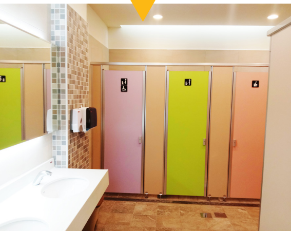
▲ 性別友善廁所施工前中後實況 (由上至下)
