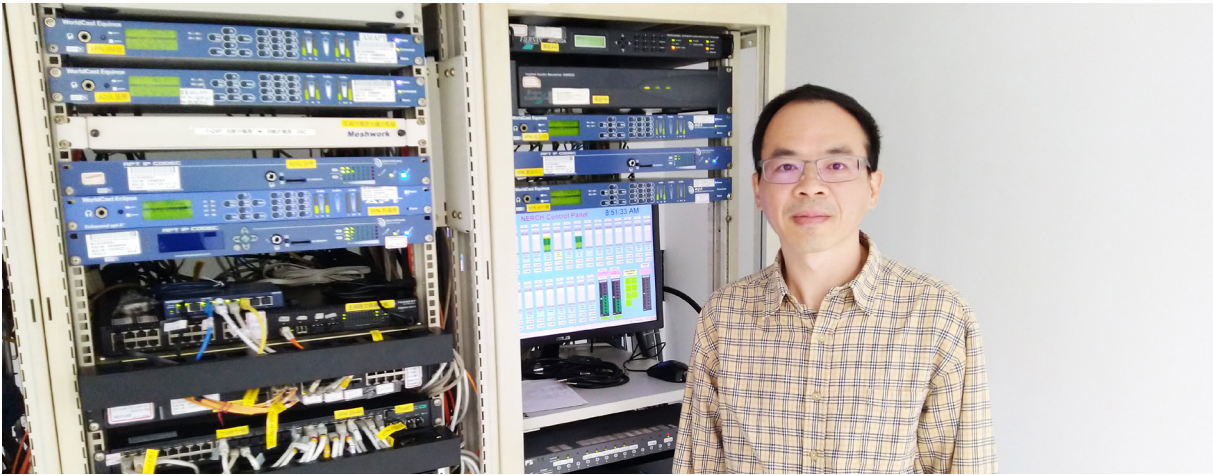
▲ 徐瑞成 - 配合裝修工程進行主控室設備維護
