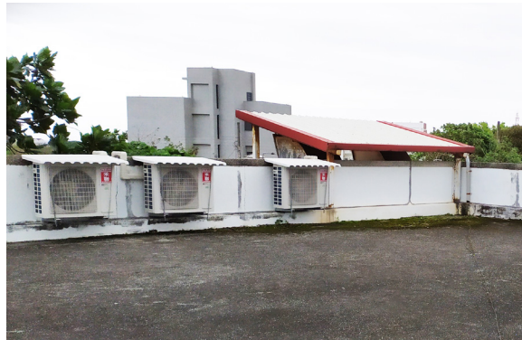
▲ 完工後室外機現況
