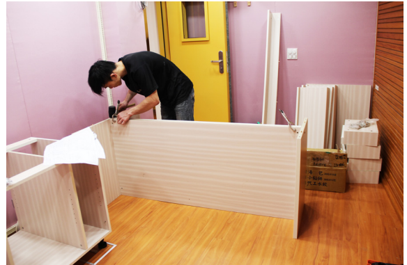
▲ 播音室牆面整修 - 機櫃組裝
